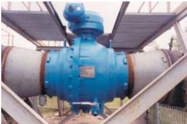
Шаровые краны «Баллостар» Ду 700, трубопровод Ду
