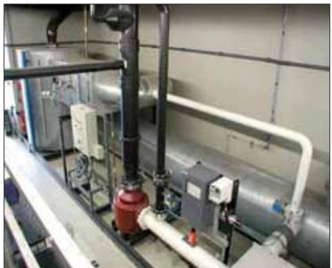
**Регенеративные системы дожигания газов** предназначены для очистки отработанного воздуха от технологического оборудования с применением керамических тепловых аккумуляторов. Благодаря использованию керамического теплового аккумулятора возможна эксплуатация без сжигания дополнительного топлива уже при незначительной концентрации растворителя. Оборудование доступно в двух- и трёхслойном вариантах.
